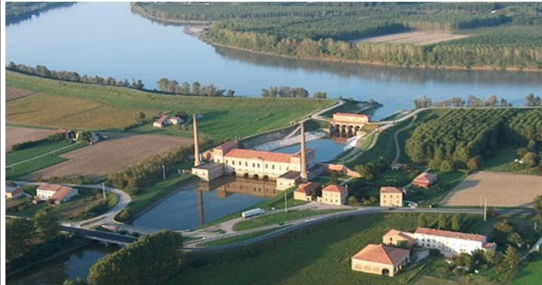
La contro-chiavica dell'impianto idrovoro della Bonifica Reggiana Mantovana di Moglia di Sermide 40
