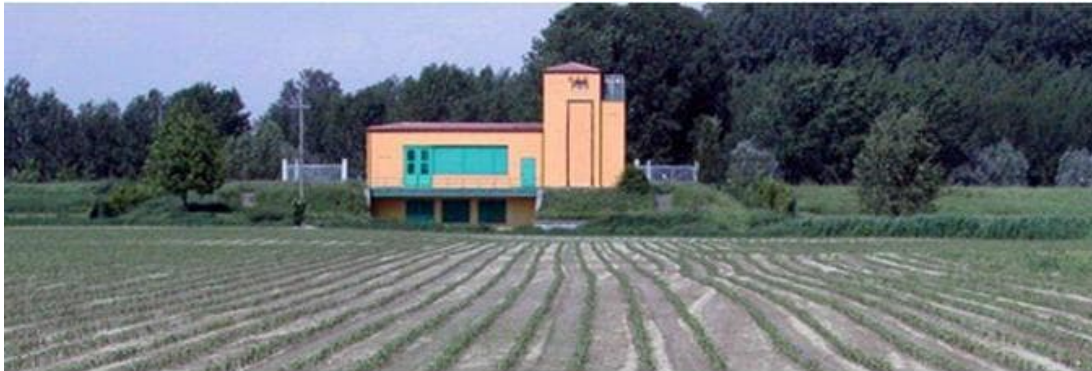
Impianto di bonifica del consorzio Muzza-Basso lodigiano. Le pompe intervengono durante le piene del Po per drenare le acque di falda che affiorano e immetterle nel fiume il cui livello è di alcuni metri sopra il terreno.
