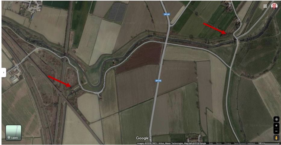
Impianti di drenaggio del territorio per ridurre gli affioramenti di falda durante la piena del Po a San Rocco al Porto
