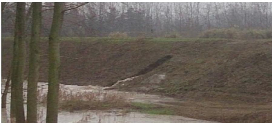
Le tane scavate lungo gli argini possono passare attraverso il manufatto. Il fenomeno avviene soprattutto per gli argini a protezione di corsi d'acqua minori dove i rilevati in terra hanno uno spessore limitato.
