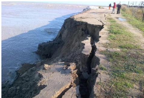
Le nutrie non scavano tane negli argini ma lungo le rive dei corsi d'acqua (fiumi e canali). Questa attività è causa di franamenti delle rive a bordo dell'acqua. Nelle figure si vedono le tane scavate dalle nutrie a pelo d'acqua lungo il fiume e collassamento di una riva a causa del cedimento innescato dalle tane.
