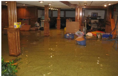
L'allagamento da infiltrazione, generalmente, è costituito da acque limpide o quasi.
