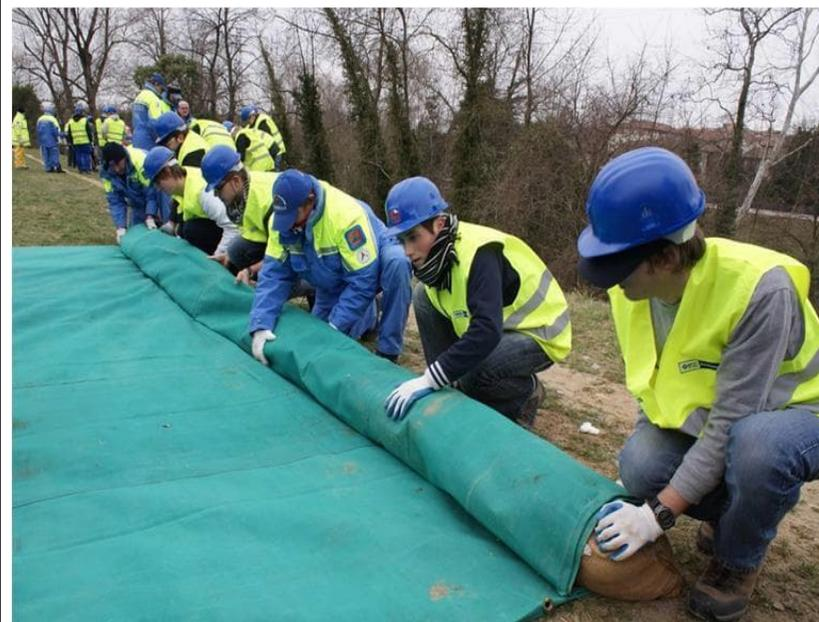
Preparazione di un telo anti infiltrazione con piena in corso
