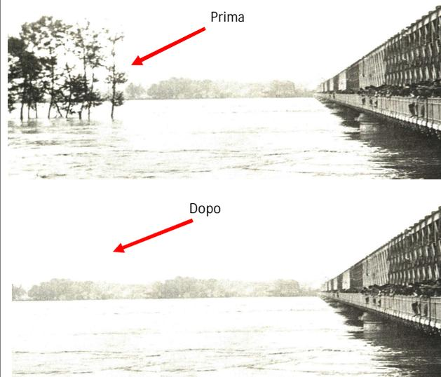
Non è facile comprendere se sono in atto fenomeni di erosione. Un sistema per capirlo è il controllo degli alberi affioranti sul livello della piena. La loro scomparsa è un'indicazione che sotto il pelo dell'acqua è in atto un fenomeno di erosione. I volontari addetti al controllo della piena dovrebbero controllare questi dettagli. In genere, storicamente, si conoscono i punti soggetti a fenomeni erosivi.
