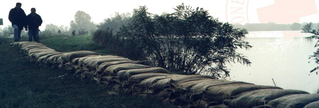
La tenuta dell'acqua della piena è garantita dalla bassa permeabilità dei componenti utilizzati per la costruzione
