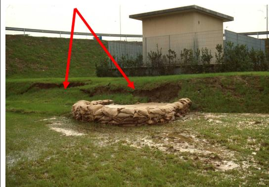
Cedimento dell'argine per sfiancamento dovuto alle infiltrazioni d'acqua e all'inzeppamento
