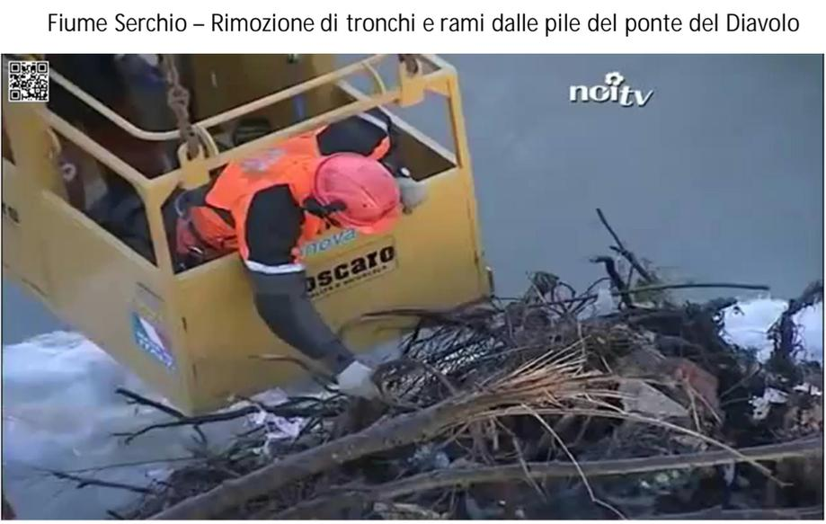
Fiume Serchio – Rimozione di tronchi e rami dalle pile del ponte del Diavolo
