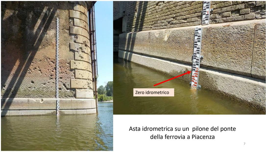
Asta idrometrica su un pilone del ponte della ferrovia a Piacenza
